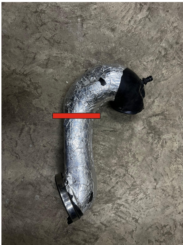
13. Обрезаем патрубок и стыкуем с соединителем 63 мм для дальнейшего подключения воздуховода.
