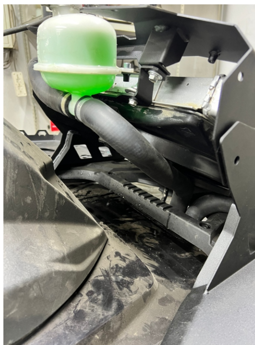
11. Подключение патрубка из комплекта к бачку. После протяжки всех соединений заливаем антифриз в систему, подключаем фишки вентилятора.
