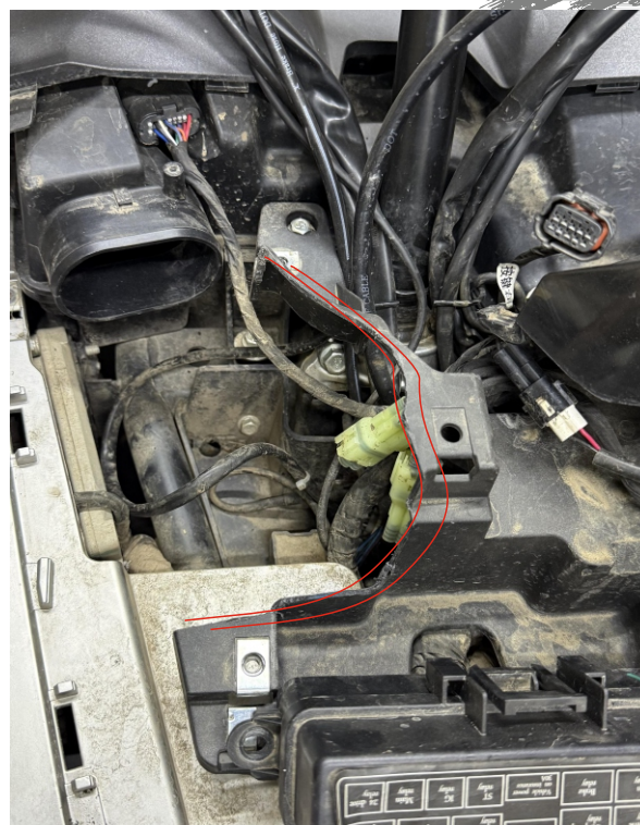
15. Демонтируем резиновый патрубок с корпуса воздушного фильтра, обрезаем пластик как отмечено на фото.
